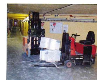
Odvoz izrezanega materiala z viličarjem
